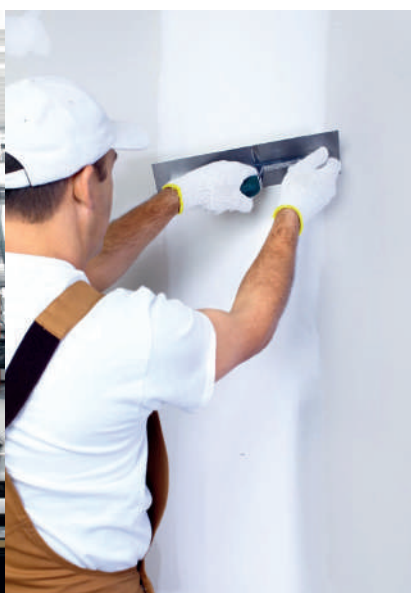
Ремонтные и отделочные работы
