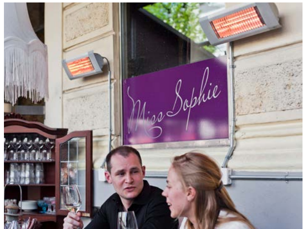
Карбоновый инфракрасный обогреватель создает интенсивный тепловой поток, однако яркость его нагревательного элемента значительно ниже, чем у его аналога с галогеновой лампой.
