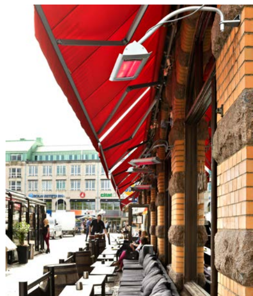
При использовании специальной штанги высота расположения самого прибора находится ниже относительно места крепления скобы на стене.
