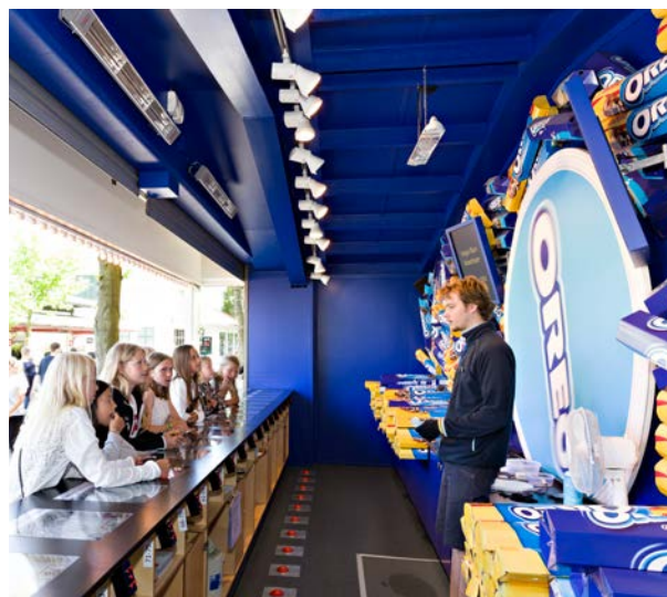
Инфракрасные обогреватели идеально подходят для обогрева на открытых площадках, поскольку тепловой поток от них воспринимается в полном объеме людьми, находящимися в зоне его действия, а не окружающим воздухом.
