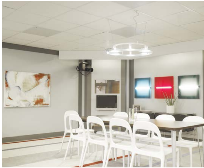
Потолочные кассеты обогревают помещение оставаясь практически незаметны. При необходимости их расположение легко изменяется
